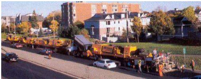
Figura 141. Equipo de recuperación en caliente de carpetas asfálticas (Campa, 2017).
