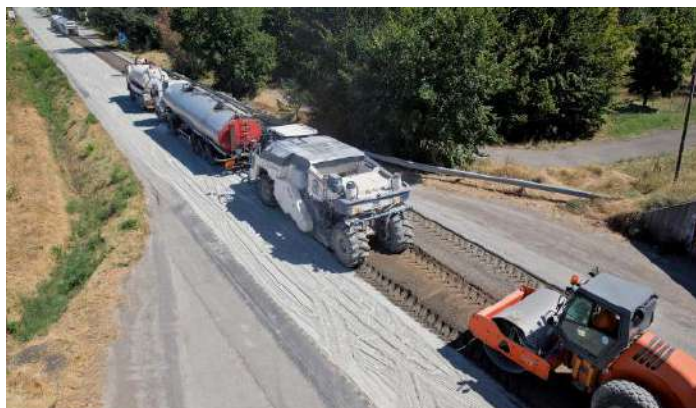
Figura 154. Tren de aplicación de un asfalto espumado (interempresas.net, 2017).
