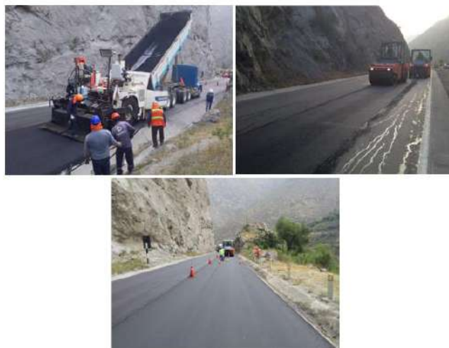
Figura 139. Aplicación de mezcla densa en caliente (Porrás, 2019).
