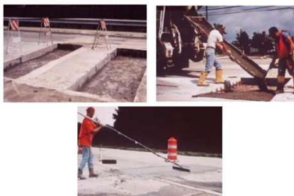
Figura 145. Intervención de losas de concreto hidráulico (Miranda, 2010).
