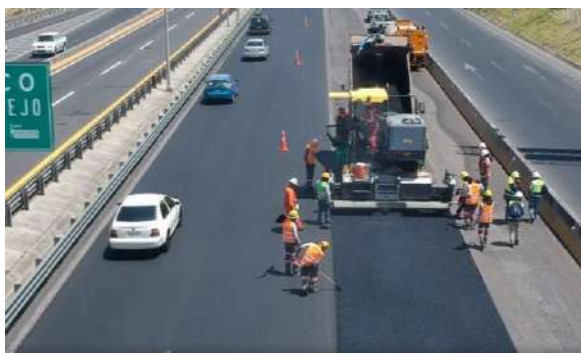
Figura 153. Tendido de carpeta asfáltica superficial altamente adherida. (Pérez, 2022)
