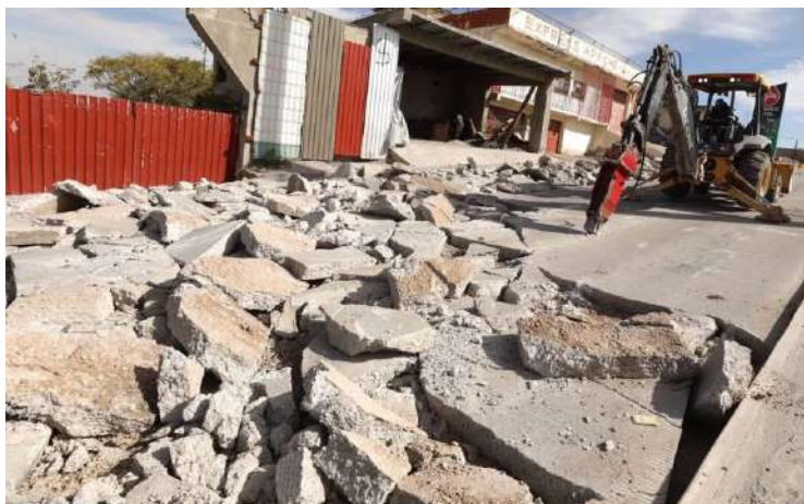
Figura 159. Demolición de losas (El Heraldo de Juárez, 2022).
