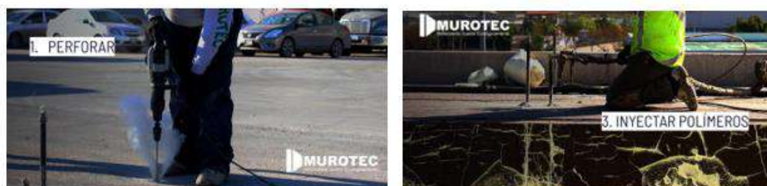
Figura 150 Estabilización de losas de concreto hidráulico (Murotecmx, 2020).
