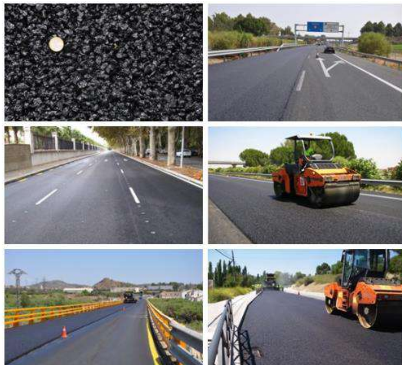
Figura 152. Aplicación de SMA en España (Costa, y otros, 2014).
