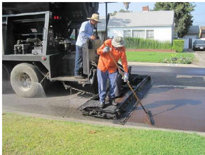
Figura 138. Aplicación de capa de rodadura con mortero asfáltico (slurry seals) (PW)
