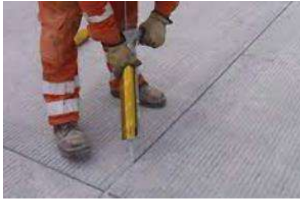
Figura 128. Sellado de grietas y juntas en losas de concreto hidráulico (Toxement, 2018).
