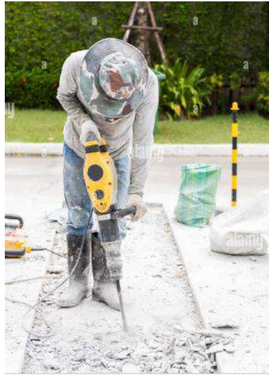
Figura 147. Reparación de desconcharuras en losas de concreto hidráulico (Almany, 2015).
