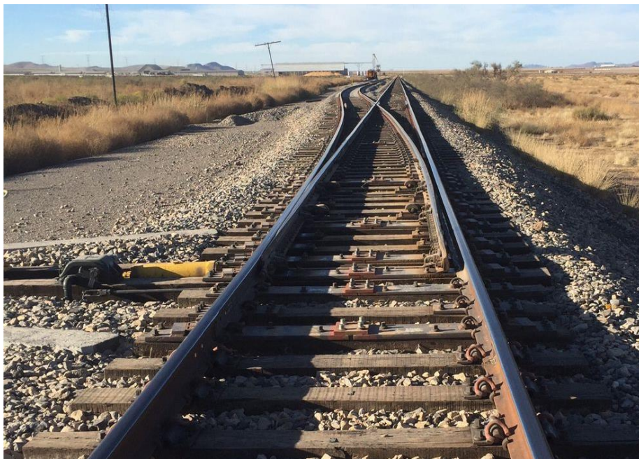
Figura 49: Vía férrea en el km 157+724 (2021).
