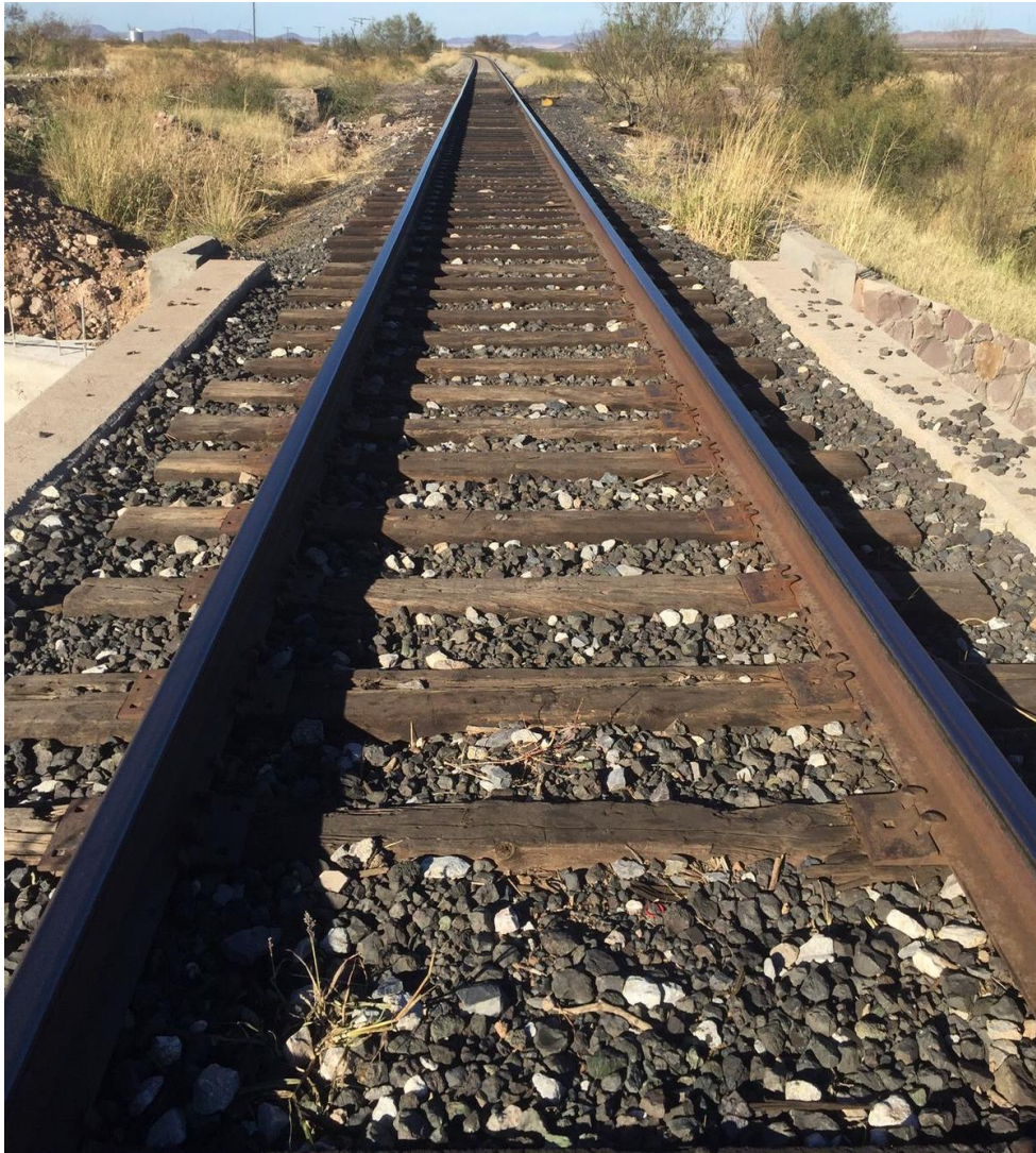
Figura 45: Vía férrea en el km 153+502 (2021).
