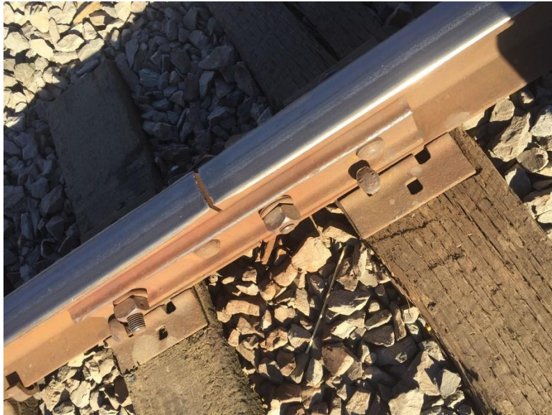
Figura 48: Vía férrea en el km 157+724 (2021).
