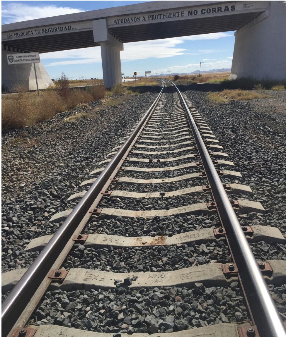
Figura 43: Vía férrea en el km 144+199 (2021).
