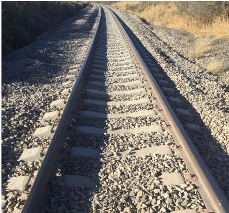
Figura 47: Vía férrea en el km 157+724 (2021).
