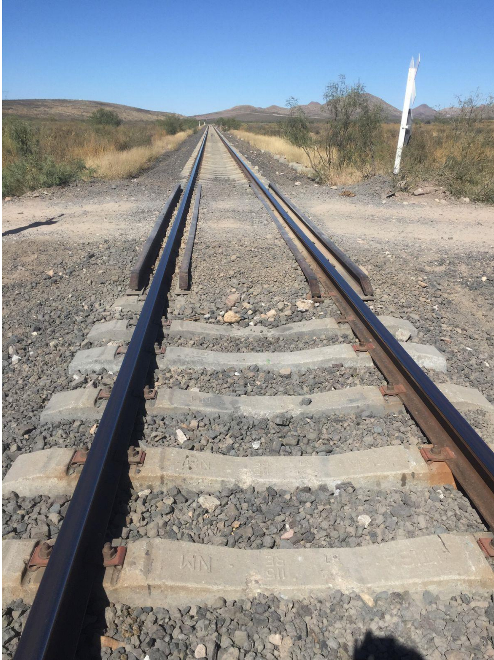
Figura 29: Vía férrea en el km 24+339 (2021).
