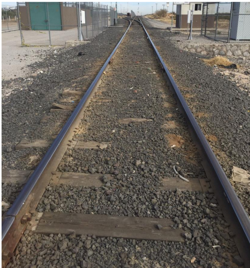
Figura 74: Vía férrea en el km 337+930 (2021).
