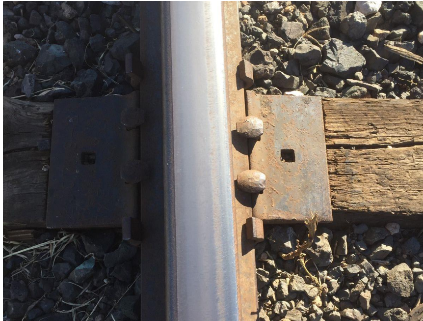
Figura 46: Vía férrea en el km 307+488 (2021)
