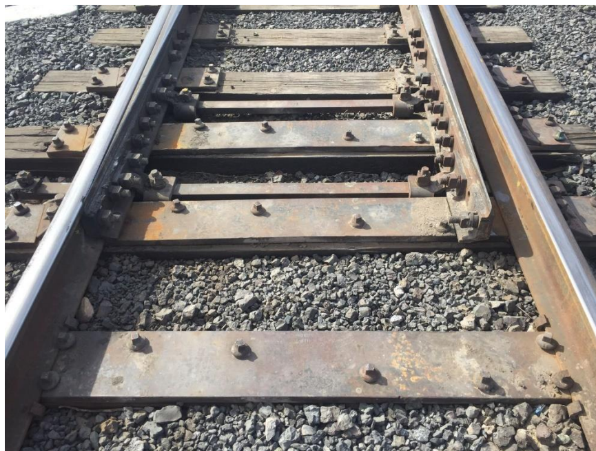
Figura 68: Vía férrea en el km 307+488 (2021)
