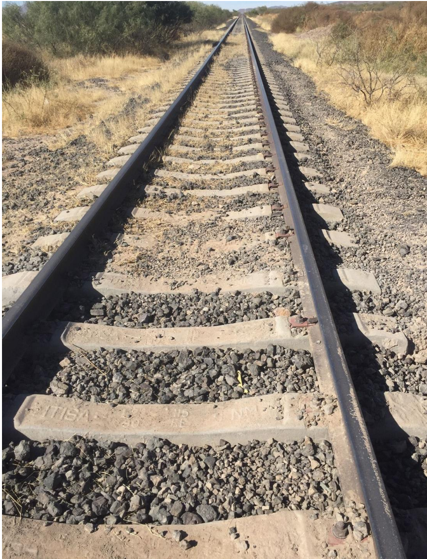
Figura 37: Vía férrea en el km 91+555 (2021).
