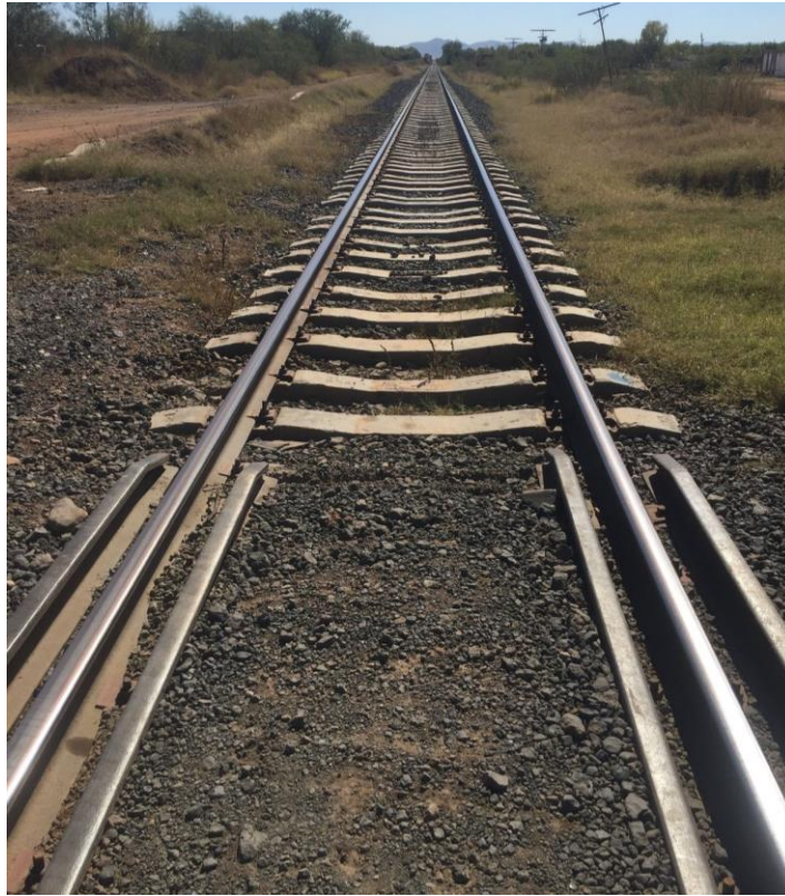
Figura 31: Vía férrea en el km 37+965 (2021).
