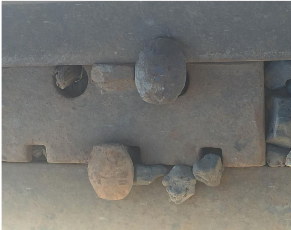
Figura 38: Vía férrea en el km 91+555 (2021).
