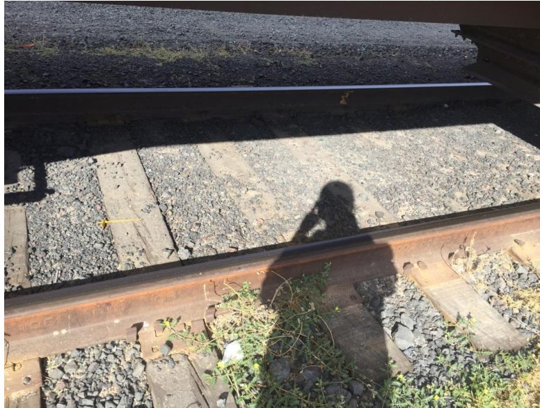
Figura 77: Vía férrea en el km 339+910 (2021).
