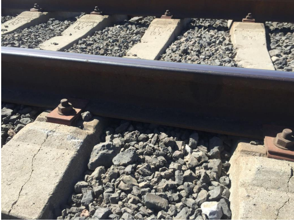
Figura 30: Vía férrea en el km 24+339 (2021).
