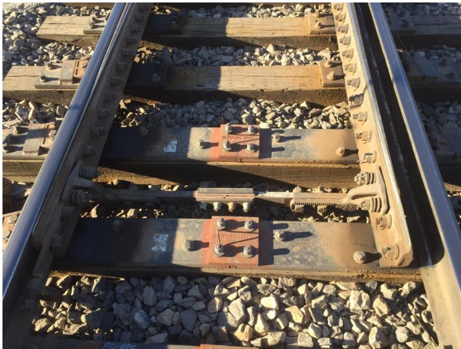
Figura 51: Vía férrea en el km 157+724 (2021).
