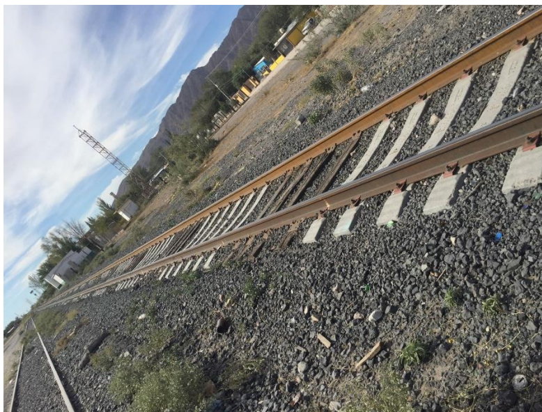
Figura 71: Vía férrea en el km 312+738 (2021).
