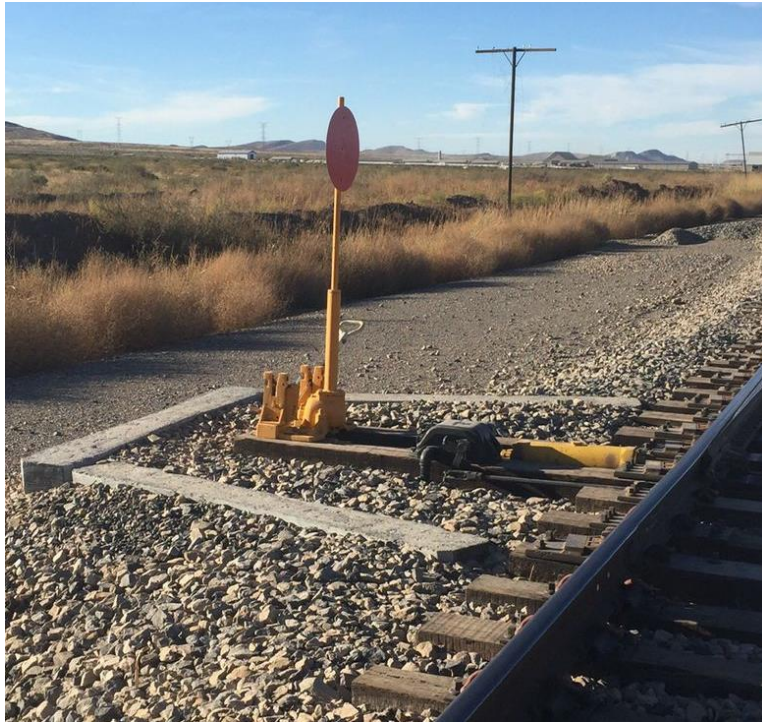
Figura 50: Vía férrea en el km 157+724 (2021).
