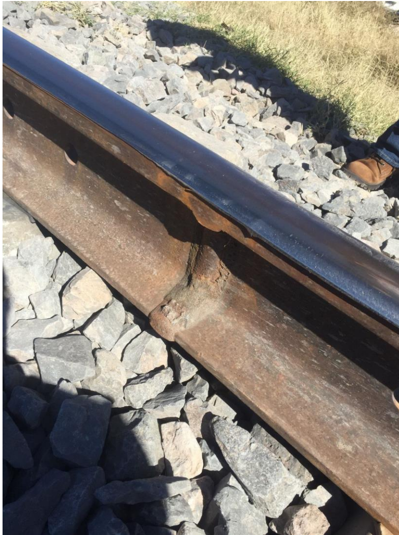
Figura 36: Vía férrea en el km 48+280 (2021).
