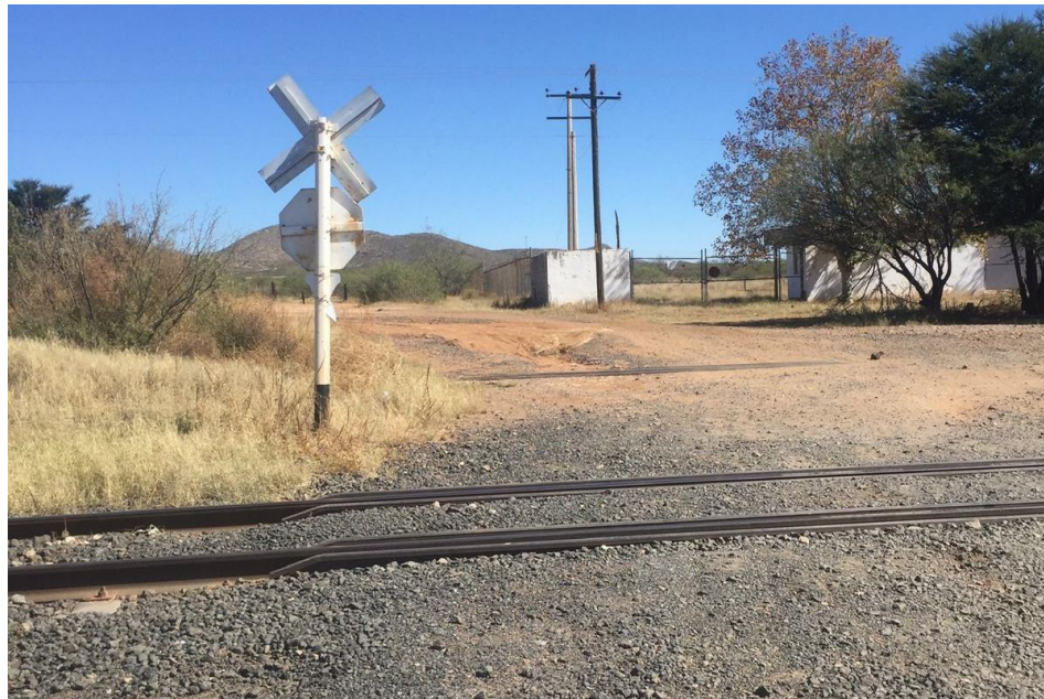
Figura 32: Vía férrea en el km 37+965 (2021).
