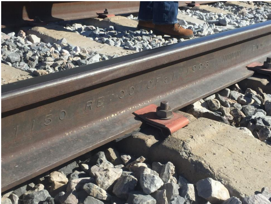
Figura 39: Vía férrea en el km 91+555 (2021).
