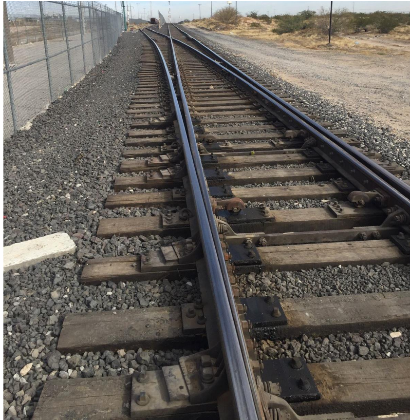
Figura 75: Vía férrea en el km 337+930 (2021).
