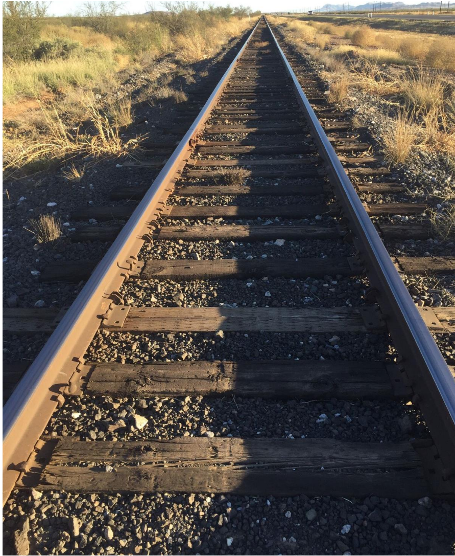
Figura 53: Vía férrea en el km 189+188 (2021).
