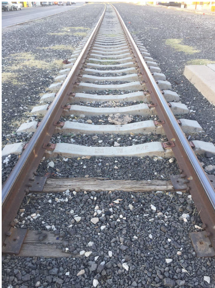
Figura 56: Vía férrea en el km 228+501 (2021).
