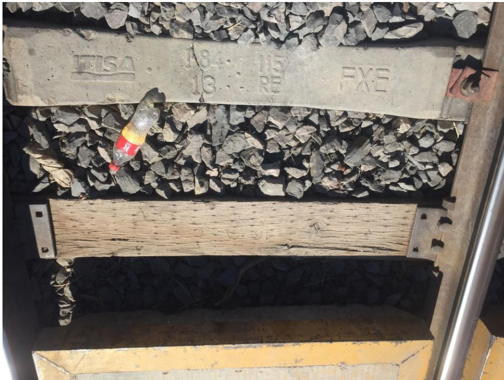
Figura 34: Vía férrea en el km 48+280 (2021).
