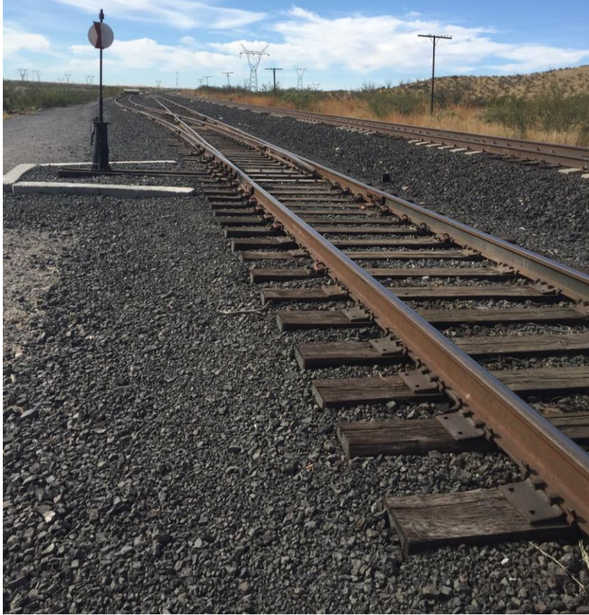
Figura 66: Vía férrea en el km 307+488 (2021)
