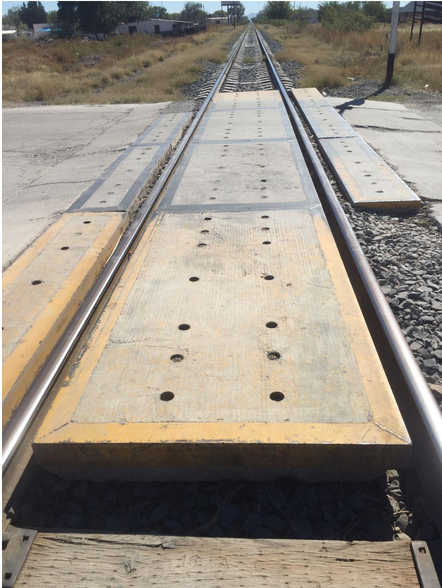
Figura 35: Vía férrea en el km 48+280 (2021).
