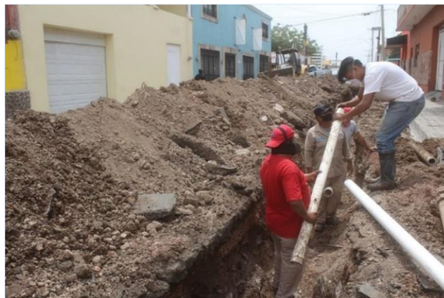
Figura 5. Detección física de fugas en redes por método destructivo (Cárdenas, 2012).
