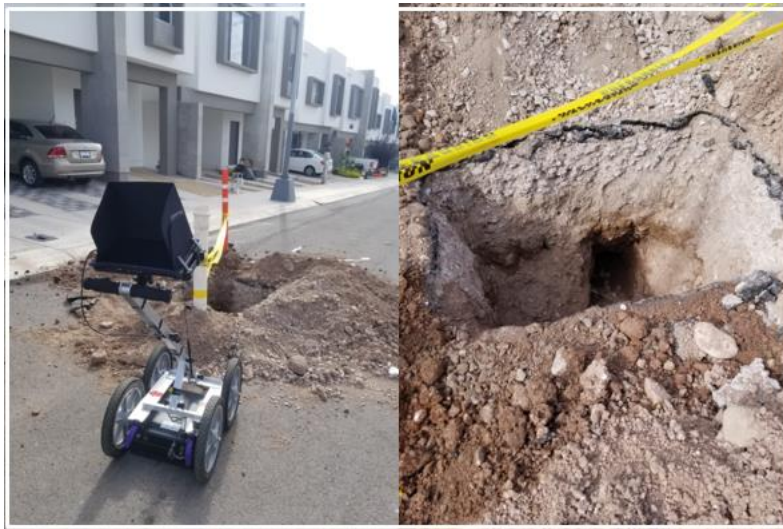
Figura 35. Excavación de suelo seco en Fraccionamiento Circuito Magenta (Fuente: Elaboracion propia)
