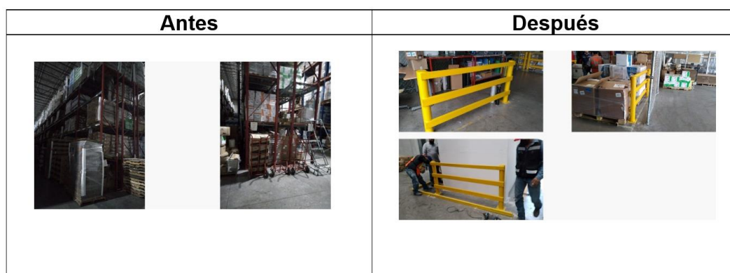
Figura 17. Resultados de colocación de guardas en el almacén.
