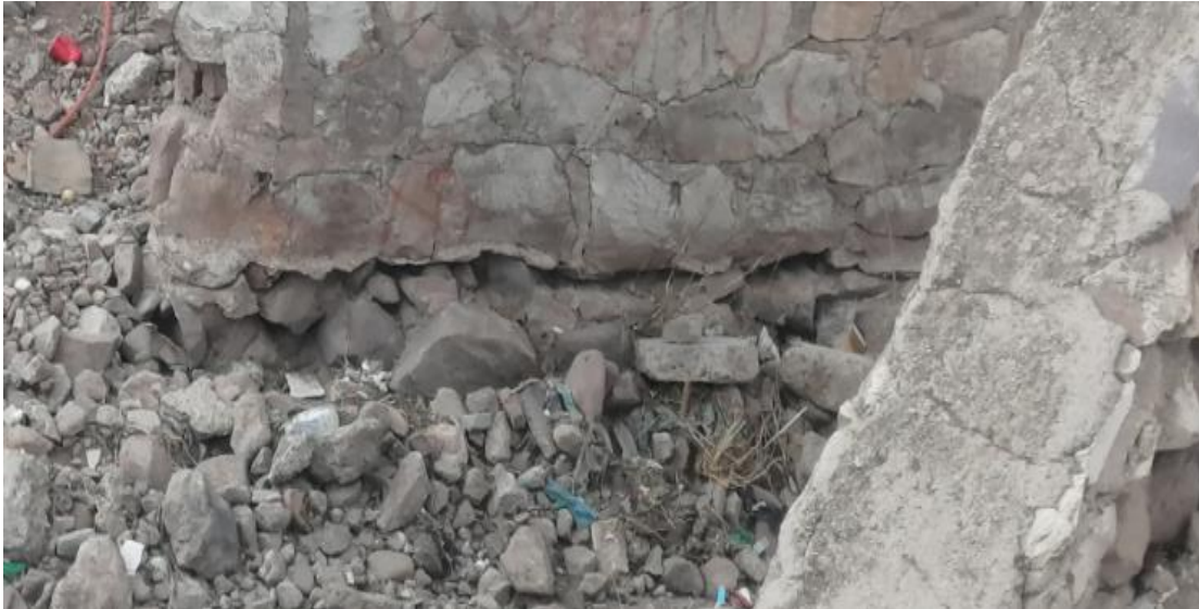
Imagen 8. Socavación de puente peatonal en el Arroyo Los Arcos. Fecha: 27/02/2021
