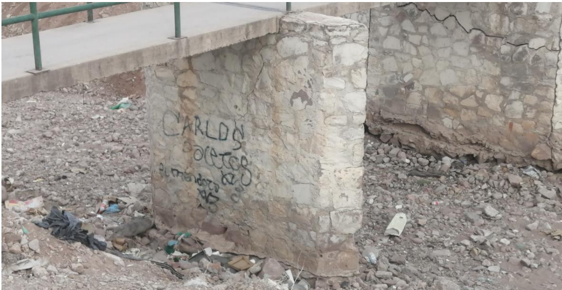
Imagen 9. Puente peatonal en Arroyo Los Arcos. Fecha: 27/02/2021
