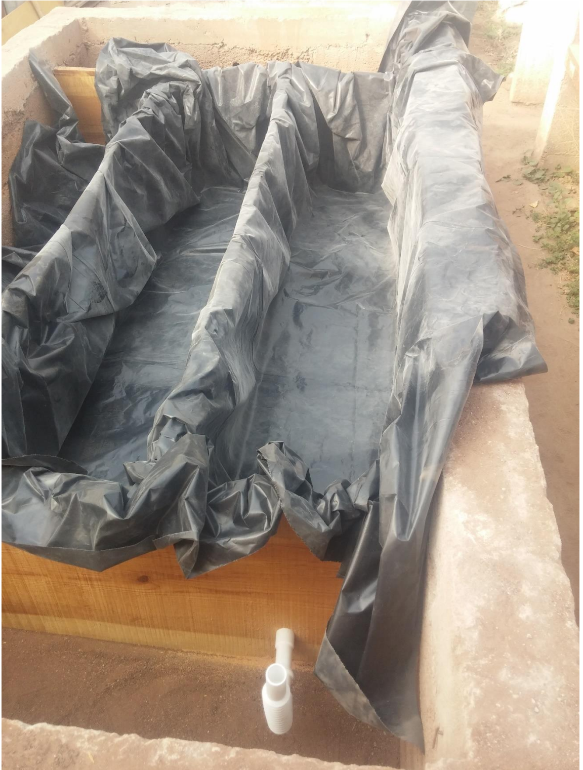
Figura 5. Impermeabilizado de las estructuras de los HCFS
