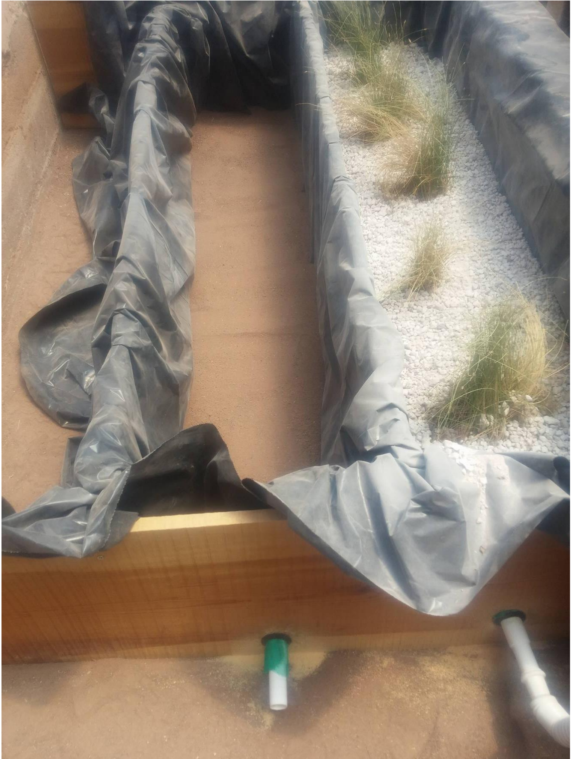
Figura 7. Instalación de impermeabilizado, sustrato, plantas y desagües.
