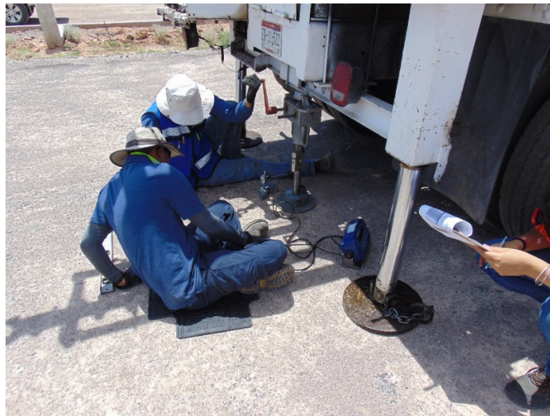
Figura 10: Prueba CBR en campo (Elaboración propia, 2020).
