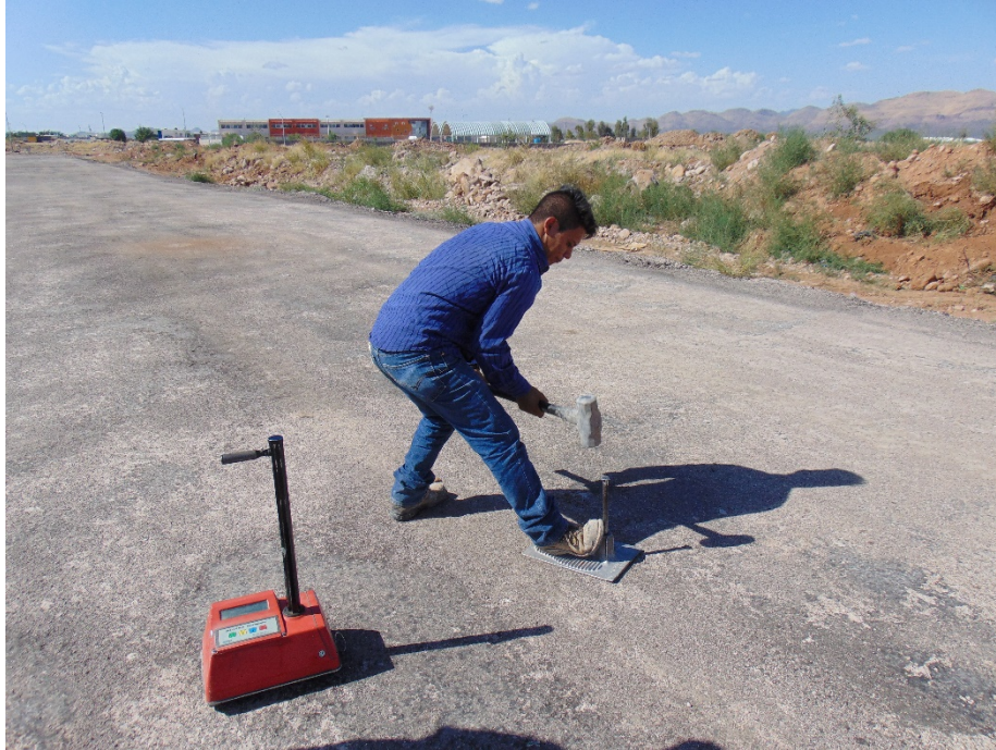
Figura 11: Verificación de compactación en plataformas (Elaboración propia, 2020).
