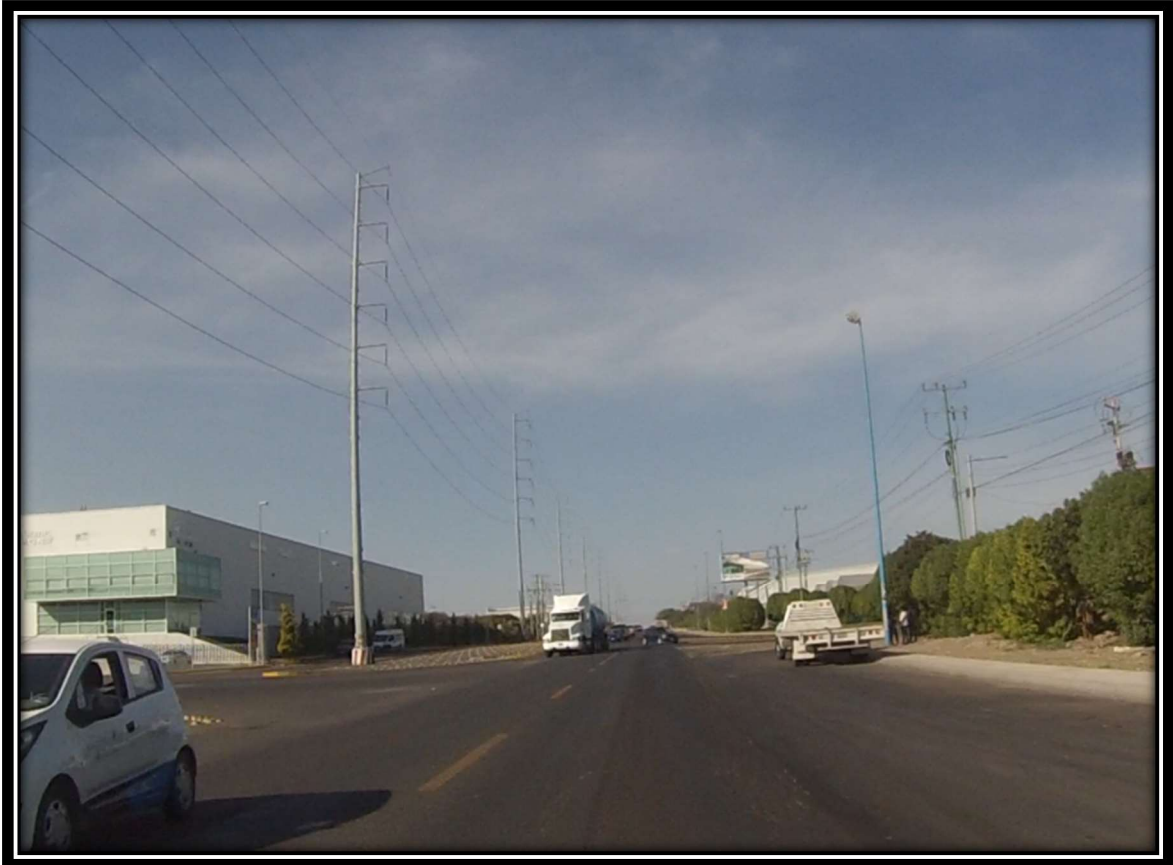
Figura 7.- Zonas de conflicto con cruces no controlados y falta de señalamiento. Fuente: Captura para la Inspección de seguridad.
