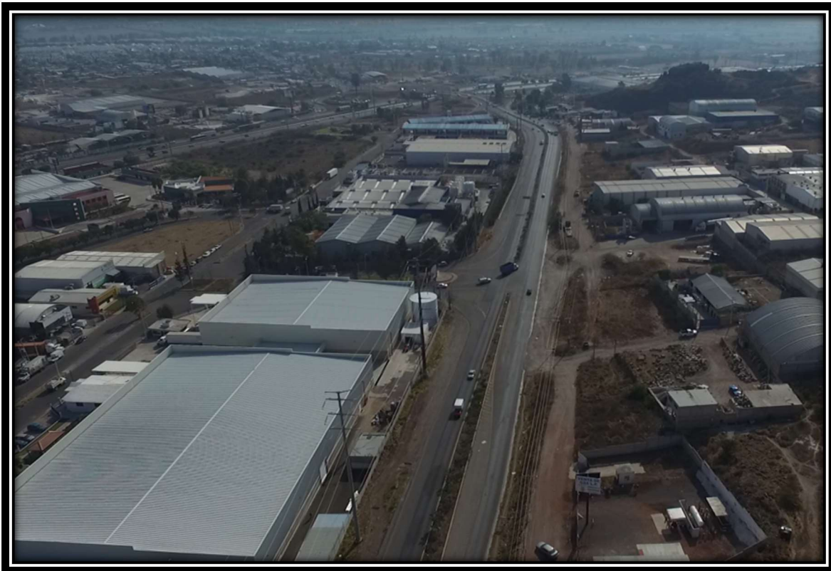
Figura 12.- Puntos de conflicto sin un orden dentro de la CE 431 km 0+400. Fuente: Captura para Inspección de Seguridad.
