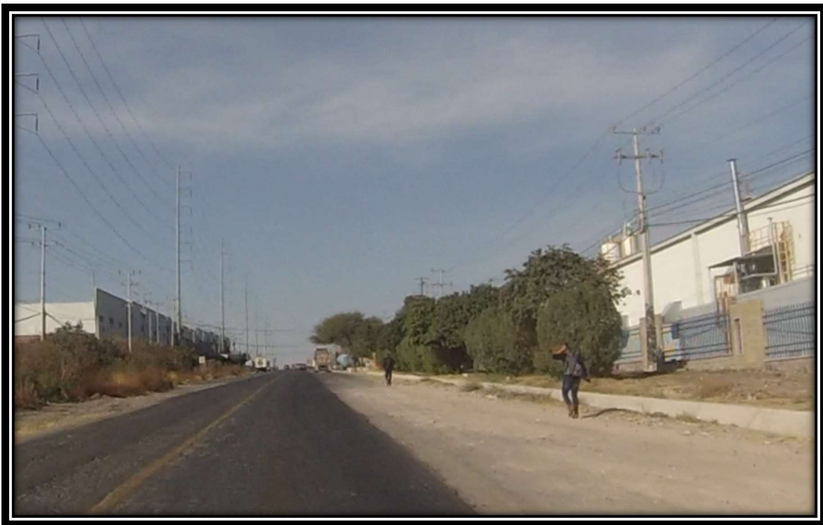
Figura 5.- Zonas peatonales inexistentes sin elementos de protección. Fuente: Captura para Inspección de Seguridad.
