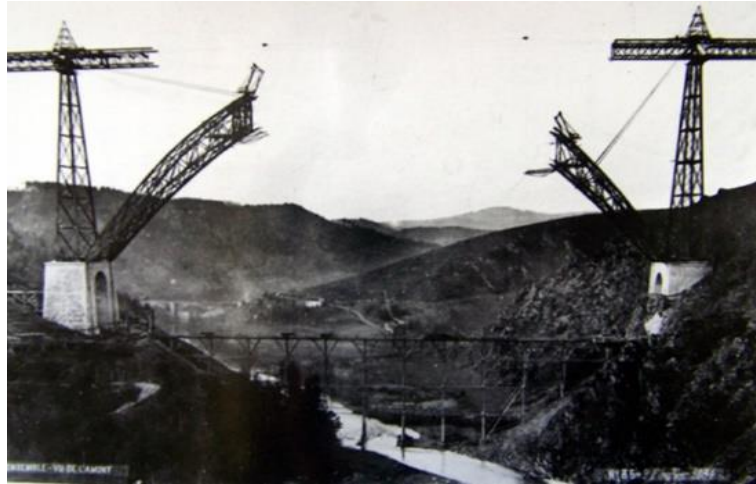
Figura 50. Primera parte, construcción del puente Garabit. Fuente: (Garabit,2016)
