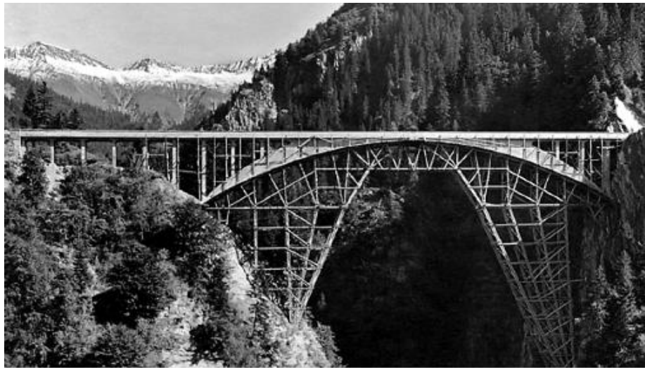
Figura 20. Puente Salginatobel. Fuente: (Da Fonseca,2016).
