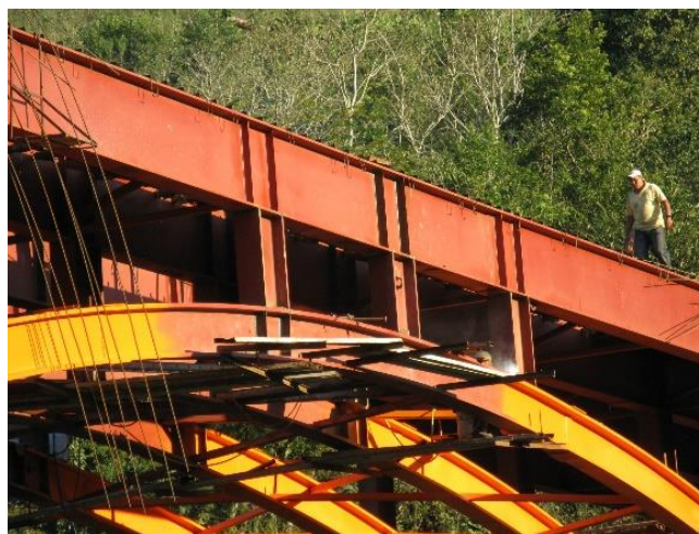
Figura 122. Vista externa de las columnas.
