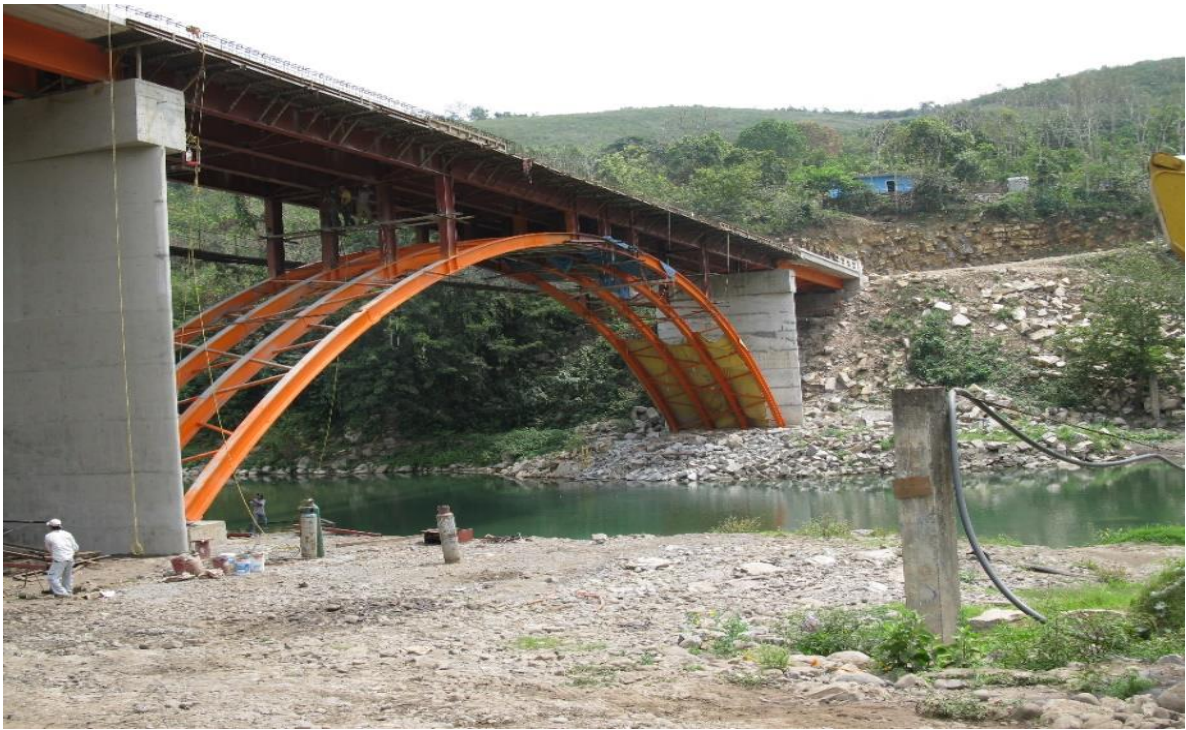
Figura 136. Puente completamente ensamblado y en acabados de pintura.
