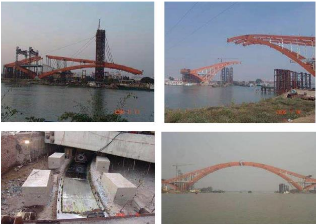
Figura 63. Fases de construcción (giro) del puente Dong Ping en China, con claro de 300 metros de longitud. Fuente: (Fan, Mu y Liang,2007).
