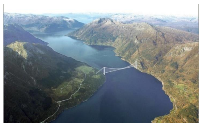
Figura 2. Puente Hardanger, vista completa del claro. Fuente: (Structuralia, 2018).
