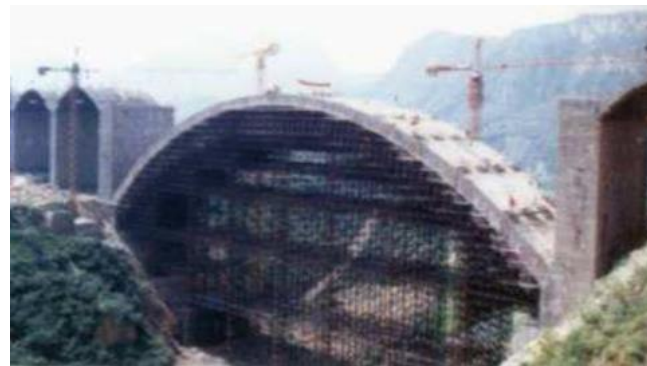
Figura 19. Proceso constructivo del puente Danhe. Fuente: (Palaoro,2011).
