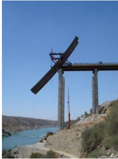
Figura 64. Puente Alconetar, en España. Inicio de la construcción, bajante. Fuente: (Gutiérrez,2018).
