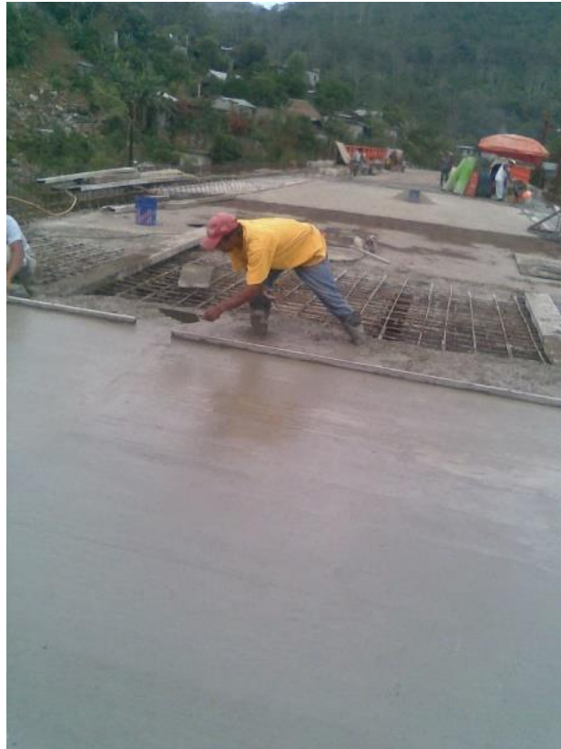
Figura 125. Colocado de la losa.
