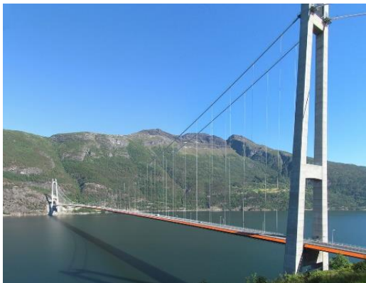
Figura 1. Puente Hardanger, tipo colgante. Fuente: (Structuralia, 2018).
