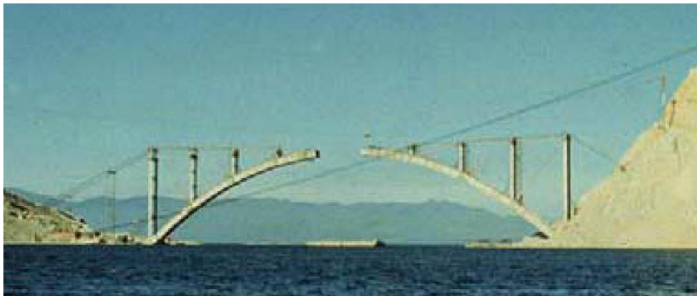
Figura 56. Construcción del puente Krk. (Fuente: Savor, Savor y Srbic,2009).
