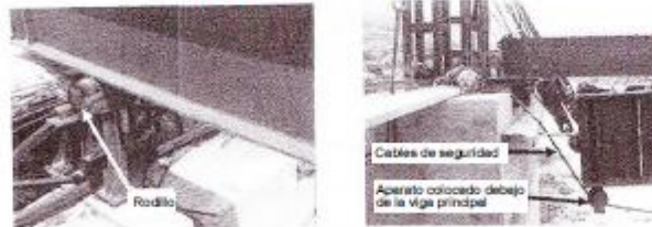
Fotografía 1 El rodillo debajo de la viga principal y la instalación de la viga principal
