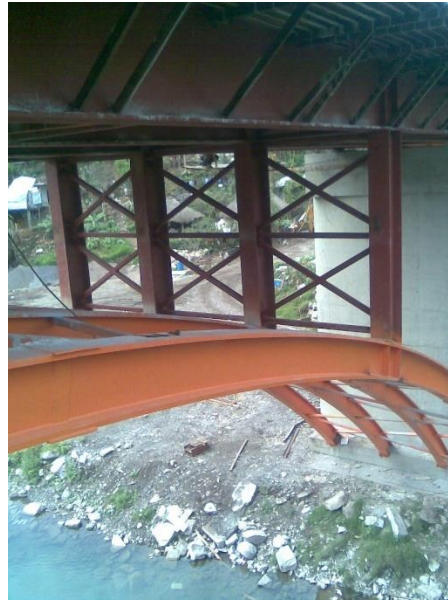
Figura 123. Vista interna de las columnas que unirán el arco con las vigas principales.
