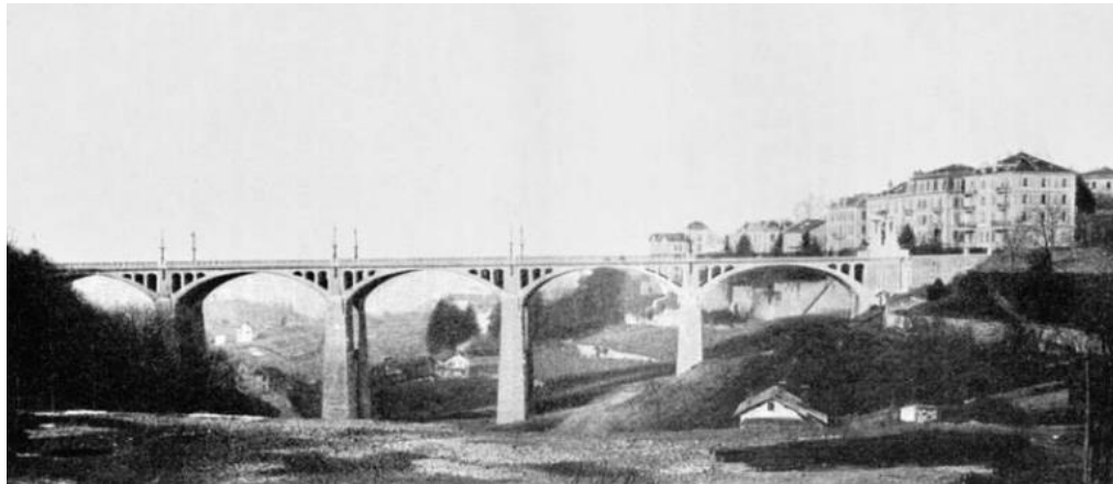
Figura 32. Puente Chauderon-Montbenon en Laussanne. Fuente: (Melan,1906).
