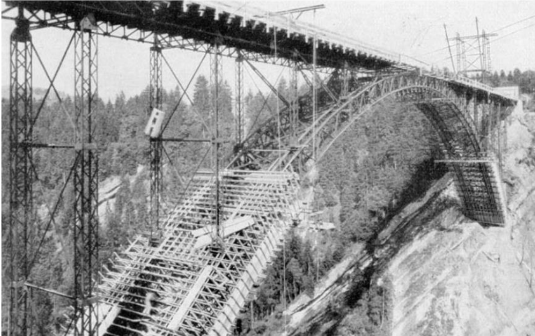
Figura 33. Construcción del puente Echelsbach. Fuente: (Duel y Gerhart,1931).
