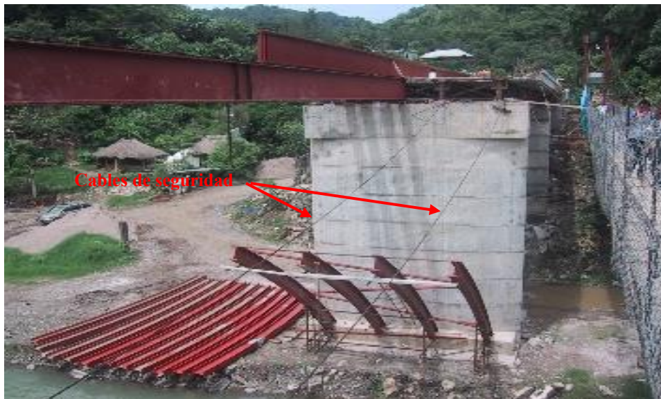
Figura 104. Colocación de cables para evitar posibles fallas en el lanzado.
