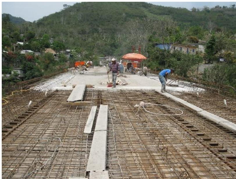
Figura 124. Colocado del acero de refuerzo en la losa que servirá como la superficie de rodamiento.
