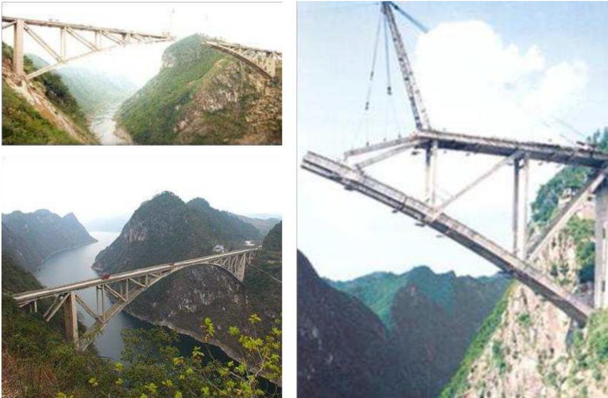
Figura 57. Puente Jangjiehe, construido en Weg'an, China, con material de concreto. Fuente (Palaoro, 2011).
