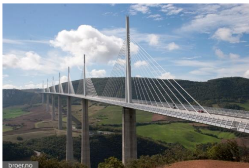
Figura 5. Viaducto Millau, en Francia, Longitud 2460 metros Fuente: (Bridgeinfo.net, 2004)
