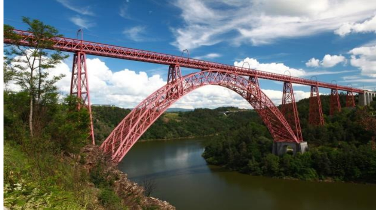
Figura 53. Puente Garabit, diseñado por Eiffel. Fuente: (Garabit,2016)
