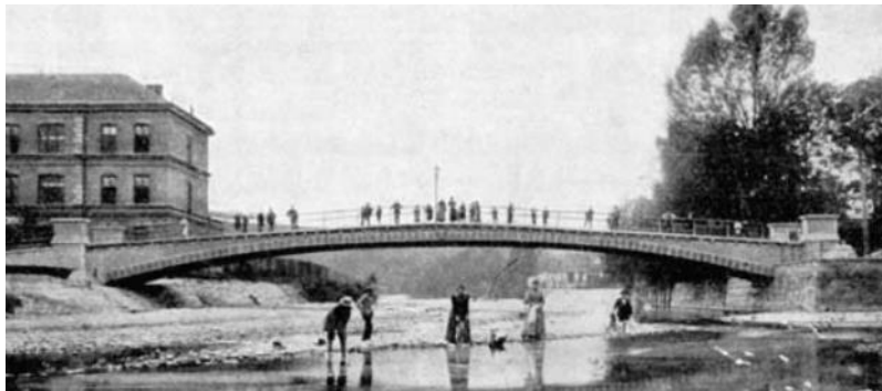
Figura 30. Puente Steyr, en Austria. Fuente: (Fritsche,1948).
