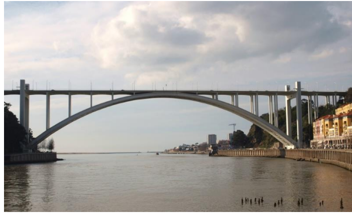
Figura 38. Puente Arrabida de Oporto. Fuente: (Plasencia,2011).
