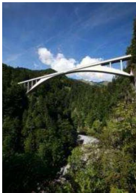
Figura 23. Construcción concluida del puente Salginatobel. Fuente: (Tapping,2007)
