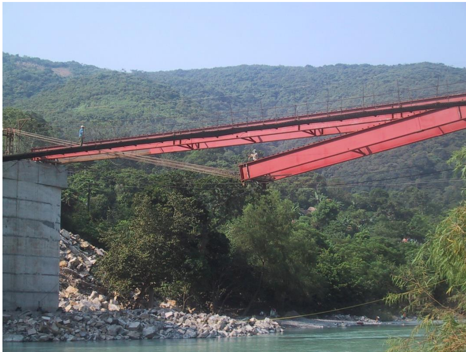
Figura 114. Vigas apoyadas en los cables de seguridad (guías).
