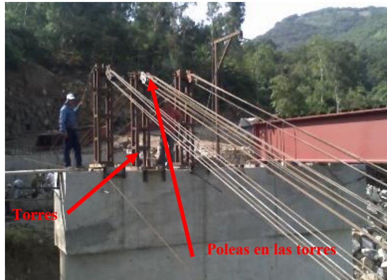
Figura 107. Columnas de celosía con la polea en su parte superior y con los cables que unen a la polea ubicada en las vigas.
