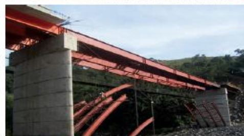
FIGURA 2. Algunas fotos del proceso de construcción.
