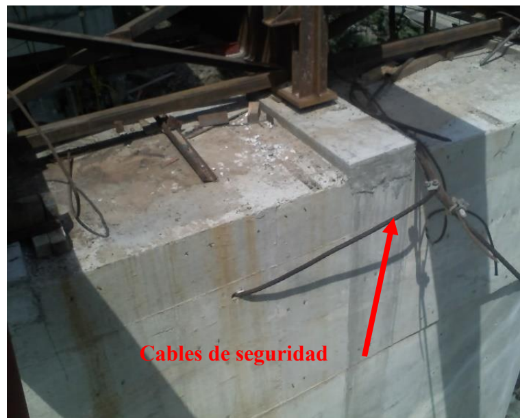
Figura 106. Colocación de los cables de seguridad amarrados al cabezal de la columna.
