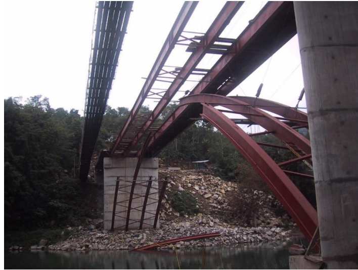
Figura 121. Vista inferior de los arcos con su respectivo contraventeo.
