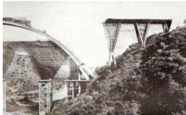
Figura 15. Colocación por piezas de la estructura del puente Bisantis. fuente: (Palaoro,2011).
