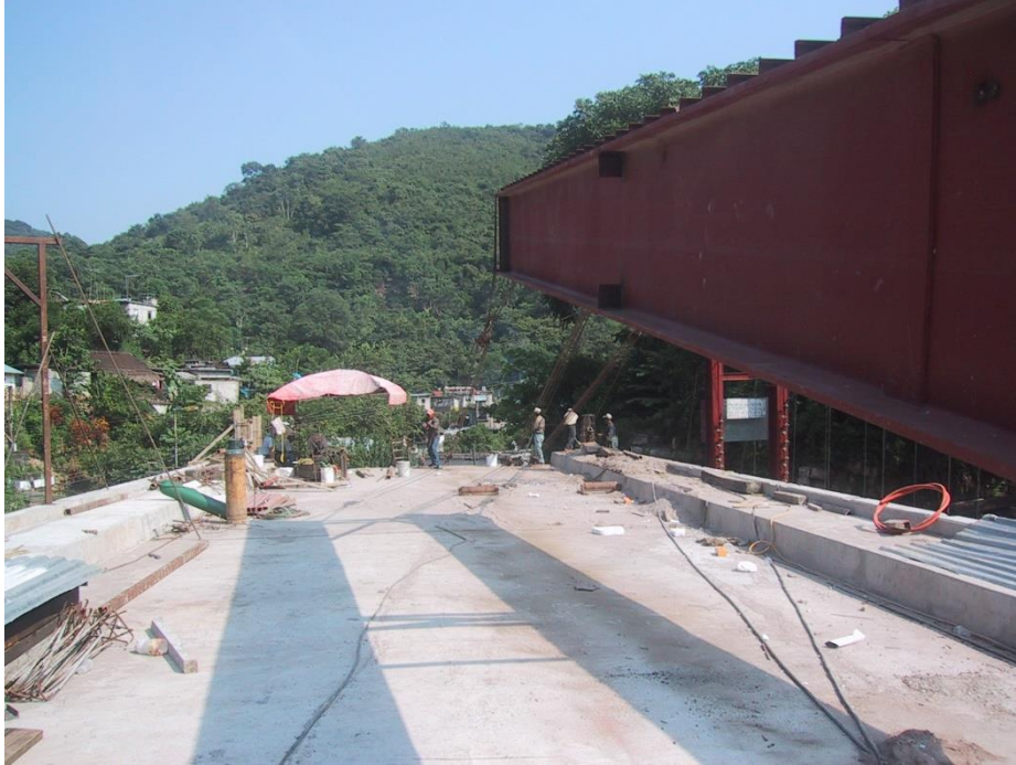
Figura 117. Separación de la viga en la parte posterior.
