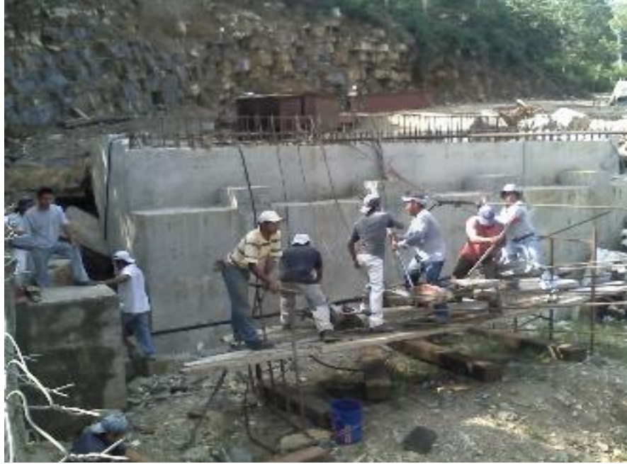
Figura 109. Trabajadores del pueblo amarrando los Tir-For al estribo y colocando el otro extremo del cable para poder jalarlo.
