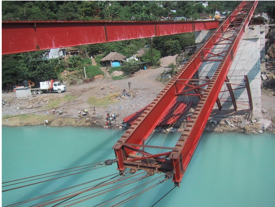
Figura 118. Vista del frente de las vigas con el sistema de jalado.
