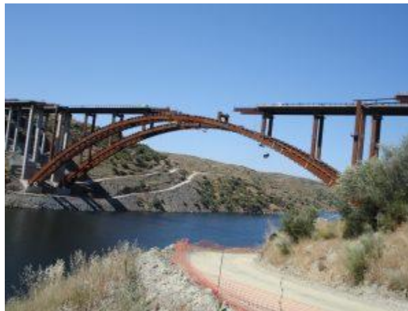
Figura 67. Colocación en la superficie de rodamiento sobre el arco unido por columnas, en puente Alconetar, en España. Fuente: (Gutiérrez,2018).
