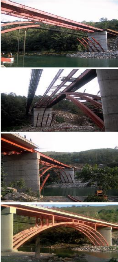
FIGURA 3. Otras fotos del proceso de construcción.
