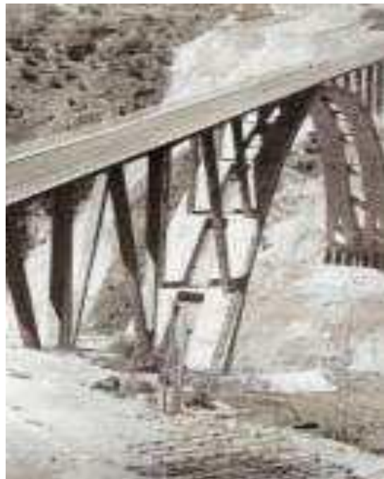
Figura 14. Parte de la base del puente Bisantis en construcción. fuente: (Palaoro,2011)
