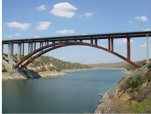
Figura 68. Puente Alconetar, en España, construcción concluida. Fuente: (Gutiérrez,2018).
