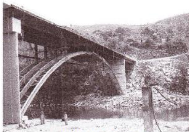
Fotografía 3 La terminación del arco
