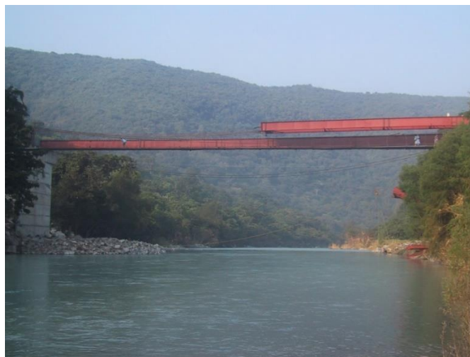
Figura 112. Momentos previos a que las vigas lleguen a la mitad y giren.
