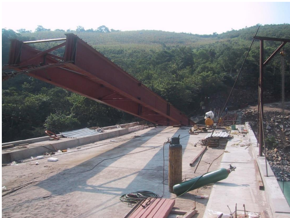
Figura 116. Parte posterior de las vigas cuando la parte central rebasó los apoyos, tipo rodillo.
