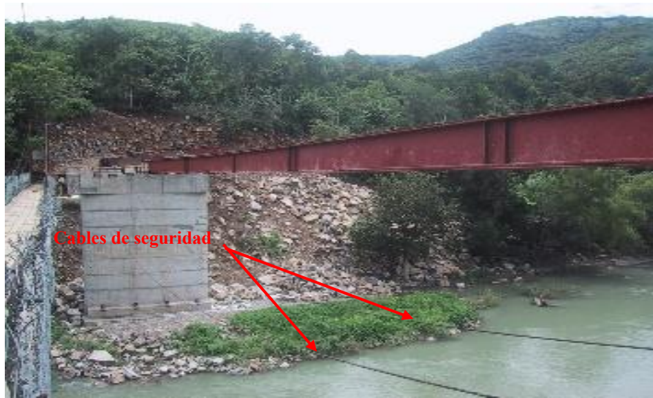
Figura 103. Colocación de los cables de seguridad, a lo largo del claro, donde se lanzarán las vigas.
