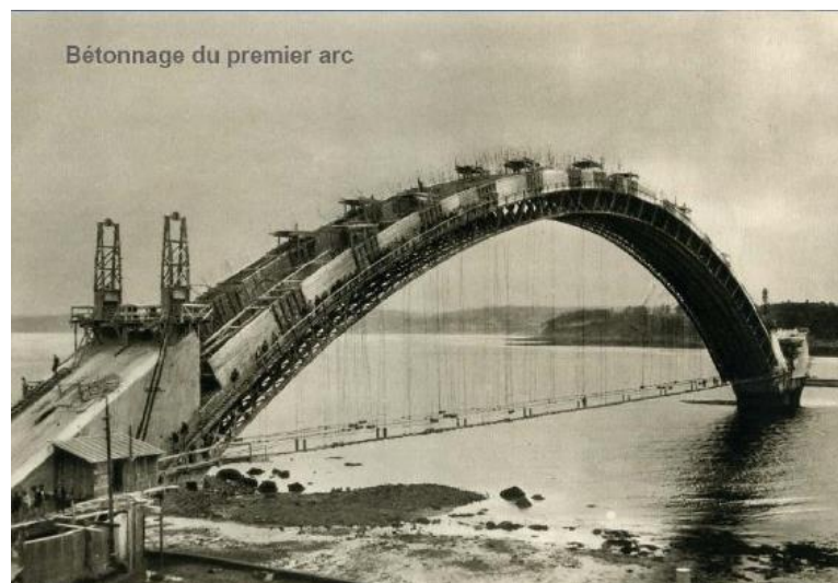
Figura 26. Colocación de la cimbra y proceso de colado de un arco. Fuente: (Slideshare,2008).
