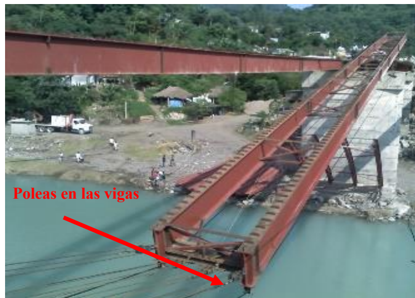
Figura 108. Cables agarrados a las poleas que son colocadas en las puntas de las vigas.
