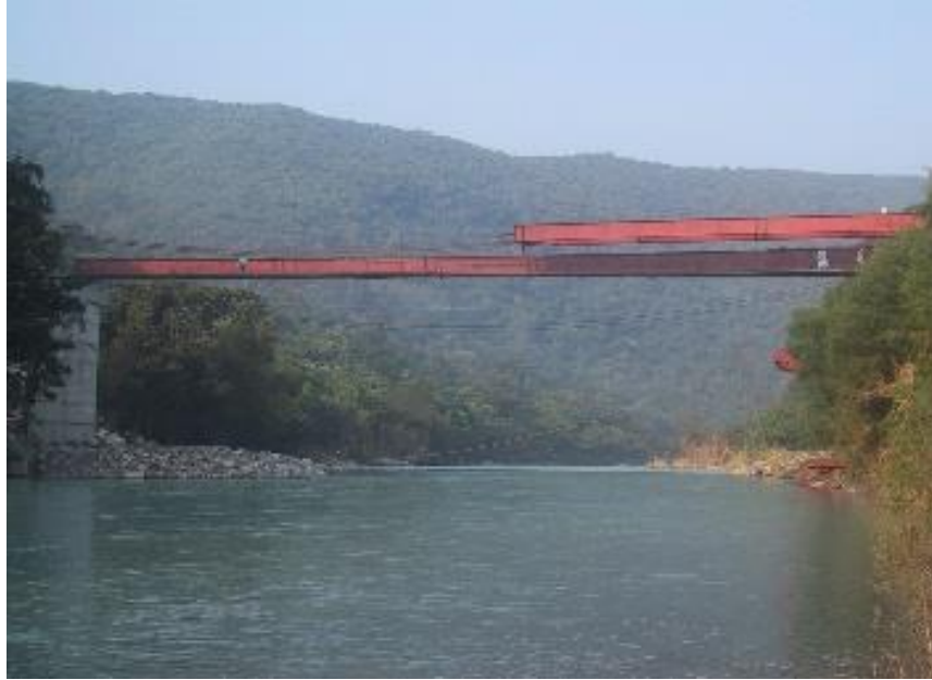
Figura 105. Colocación de las vigas.
