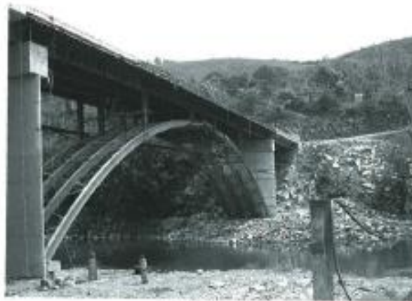
写真-3 アーチの完成
