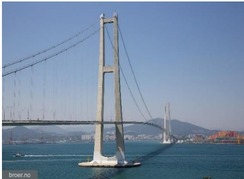
Figura 3. Puente Yi Sun-sin Corea, tipo colgante. Longitud 2260 metros. Fuente: (Bridgeinfo.net,2012)
