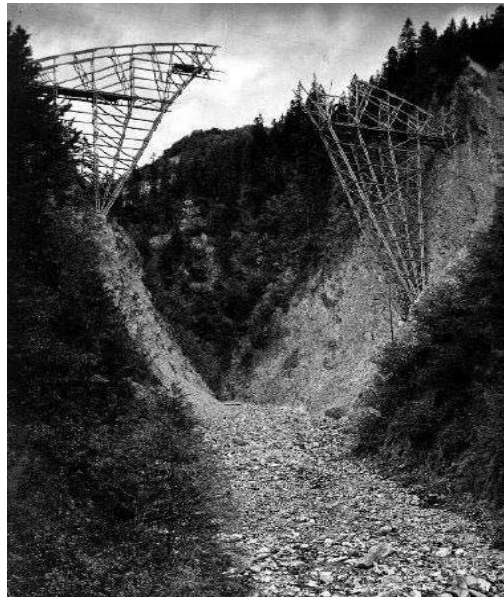
Figura 22. Proceso de construcción de la cimbra. Fuente: (Tapping,2007)
