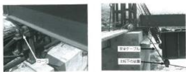
写真-1 主桁下のローラおよび主桁の搬送
