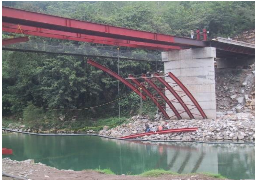
Figura 119. Vigas como grúas viajeras ayudadas por un carrito conectado a una polea al resto del arco.
