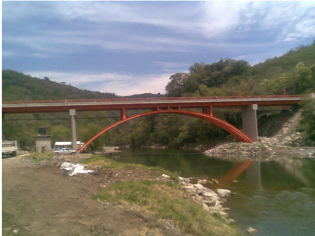
Figura 137. El puente terminado.
