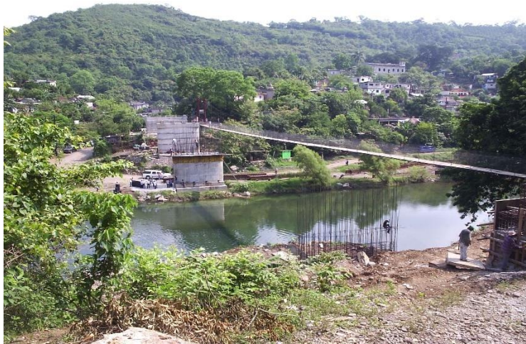
Figura 88. Puente peatonal existente.
