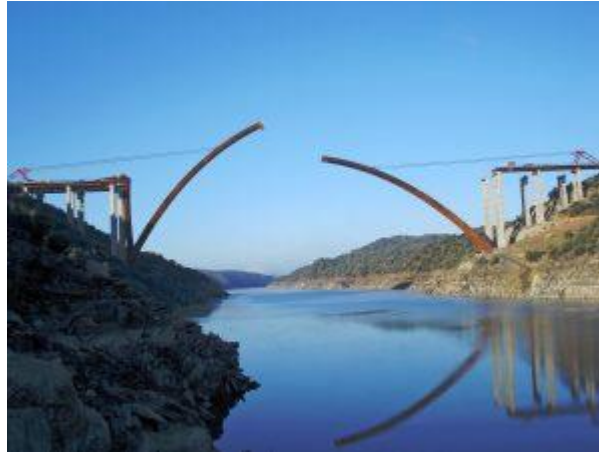
Figura 66. Colocación de semiarcos por el método de rotación vertical con giración de arriba hacia abajo en puente Alconetar, en España. Fuente: (Gutiérrez,2018).
