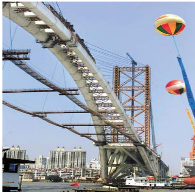
Figura 45. Construcción del arco del puente Lupu. Fuente: (Ellis,2007).
