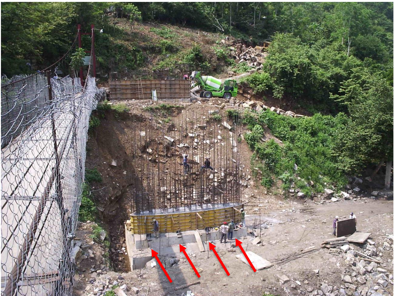
Figura 100. Vista de las pilas elípticas huecas y los cuatro muñones ahogados en la cimentación, como principio de los arcos.
