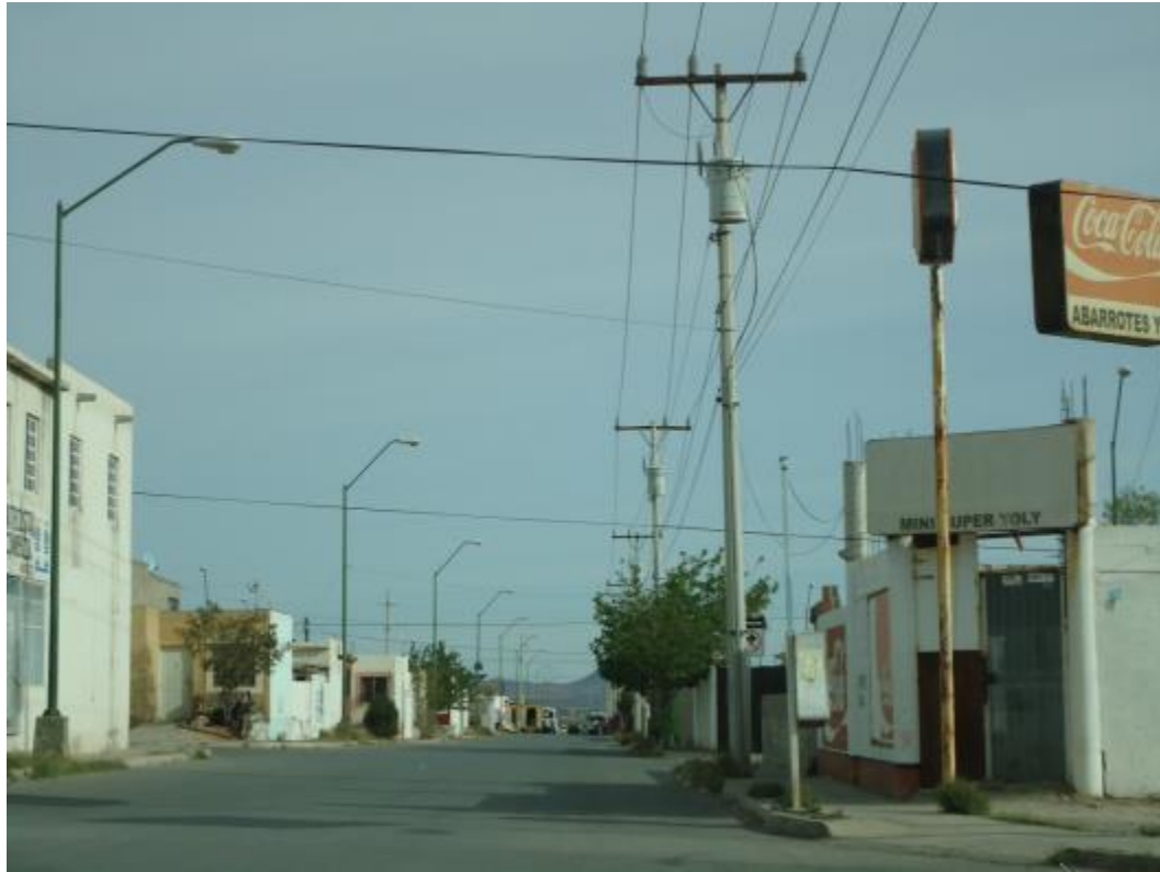
Imagen 3.4: Infraestructura. Electrificación, alumbrado.
