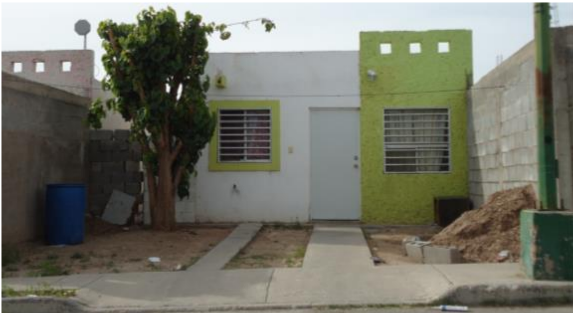
Imagen 3.1: Estado actual de viviendas
