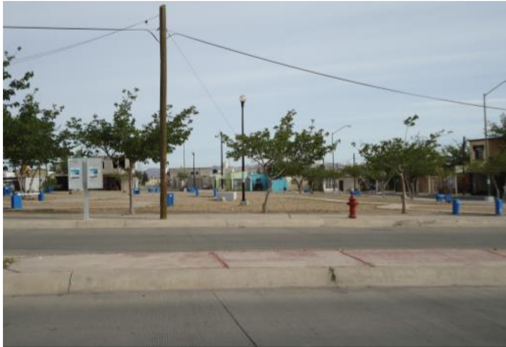
Imagen 3.2: Infraestructura. Cableado aéreo, banquetas, pavimento
