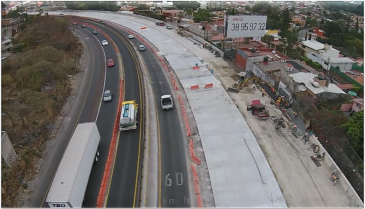
Figura 20 Tendido de pavimento hidráulico.
