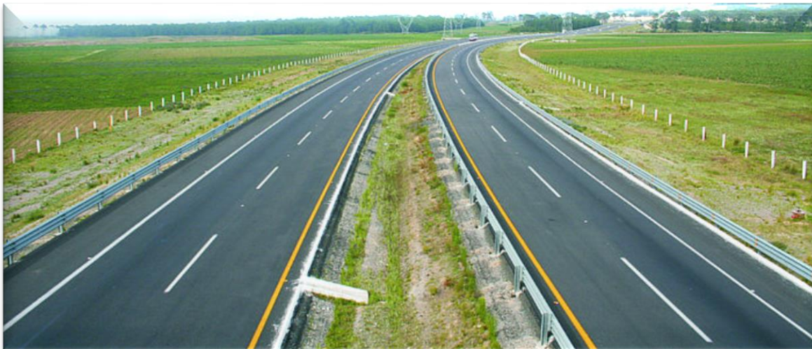
Figura 4 Cercado del derecho de vía en Libramiento de Hermosillo, SCT.
