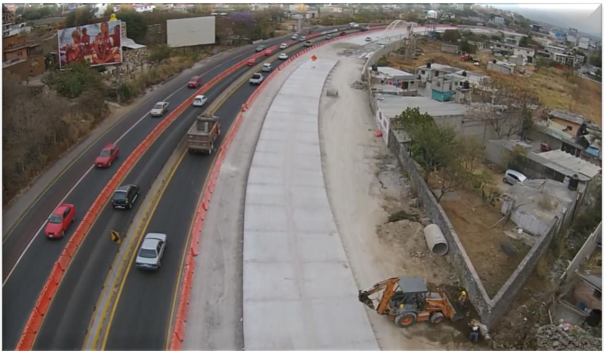
Figura 21 Limpieza posterior a los trabajos, lado derecho.
