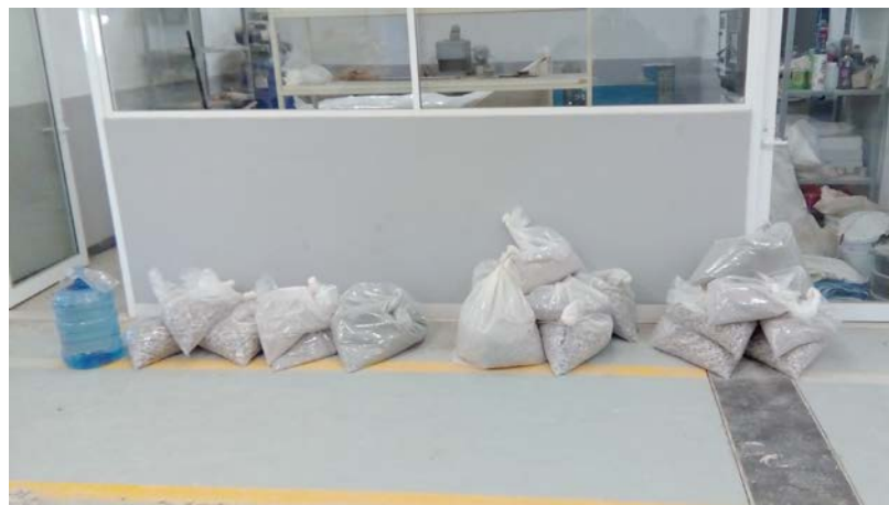
Figura 3.4- Preparación de los componentes del concreto.
