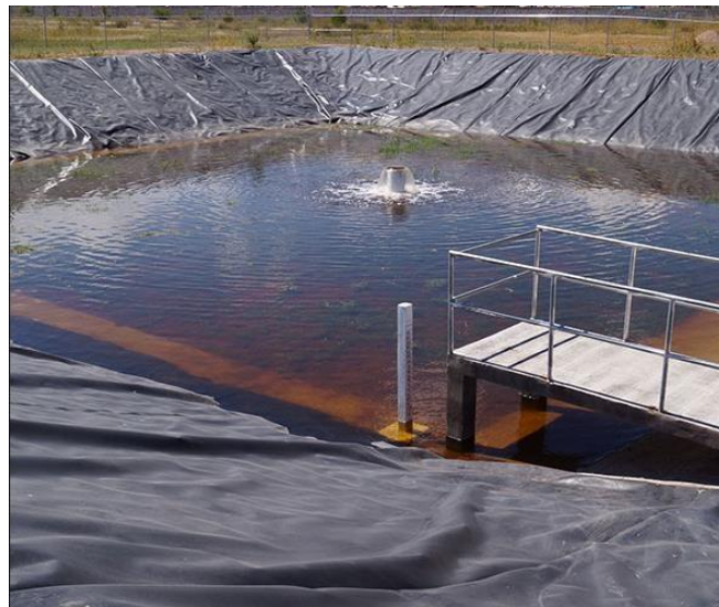
Figura 3(b).Balsa de infiltración en Chihuahua.
