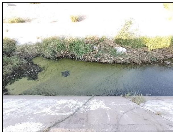
Figura 50. Fotografías del segmento con maleza y agua estancada
