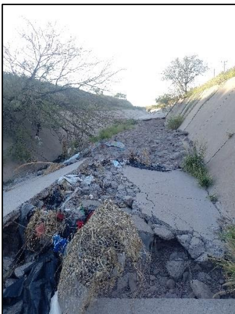
Figura 46. Fotografías del segmento destruido y conglomerado
