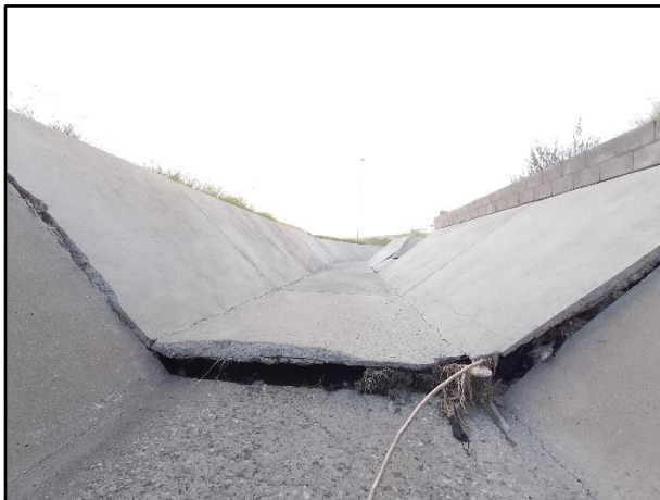
Figura 53. Fotografías del concreto levantado
