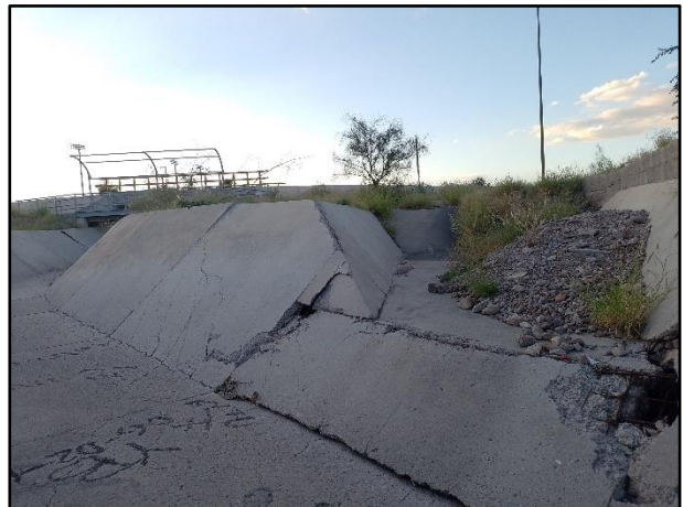
Figura 53. Fotografías del concreto levantado
