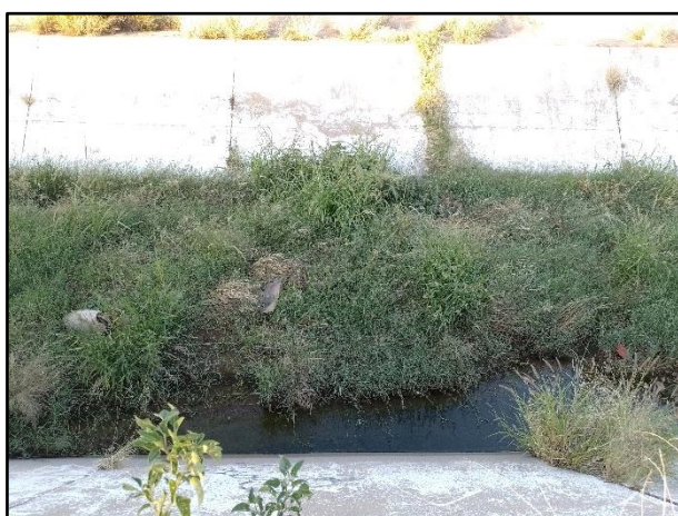
Figura 50. Fotografías del segmento con maleza y agua estancada
