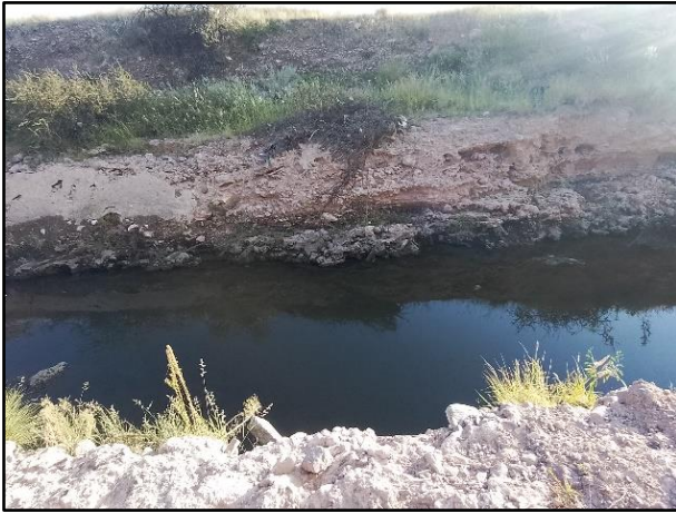
Figura 48. Fotografía del segmento destruido y arcilla
