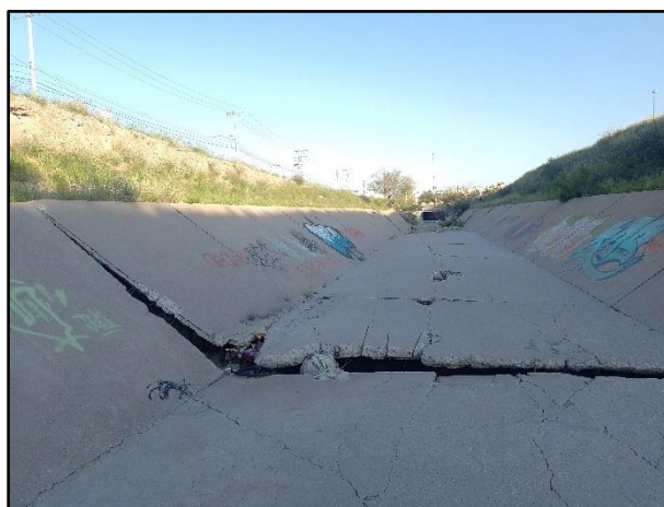
Figura 47. Fotografía del segmento canalizado
